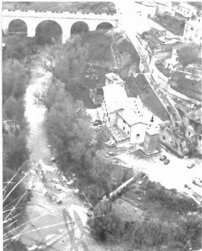
Sopra: Serie di briglie realizzate dal Consorzio lungo l'asta del torrente Castellano nel tratto che attraversa l'abitato di Ascoli Piceno sotto la Fortezza Pia.
