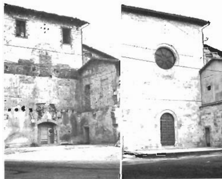
Il complesso della "parrocchia" dei Ss. Pietro e Paolo come era prima della ristrutturazione e come si presenta oggi.
