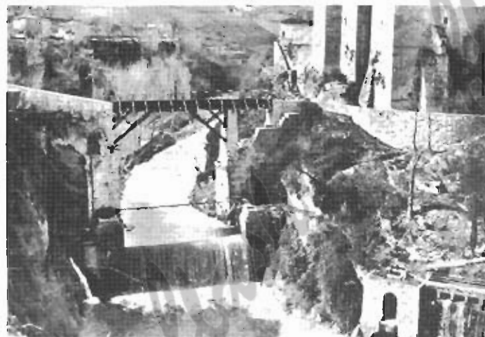
Nel 1944, durante la ritirata dei tedeschi, il "ponte" fu fatto saltare. Per permettere il passaggio pedonale fra le due sponde, fu approntata una passerella di legno
