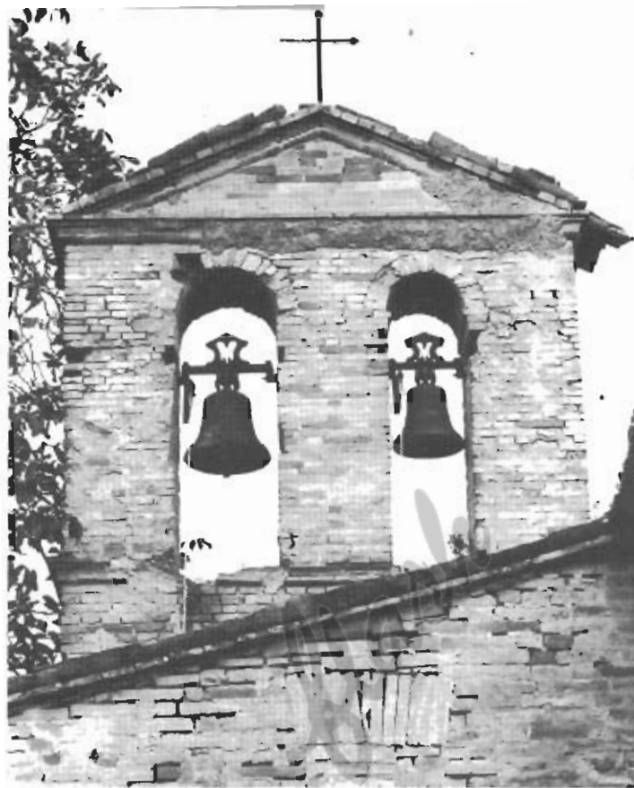
Campane di Cerreto (fuori uso)
