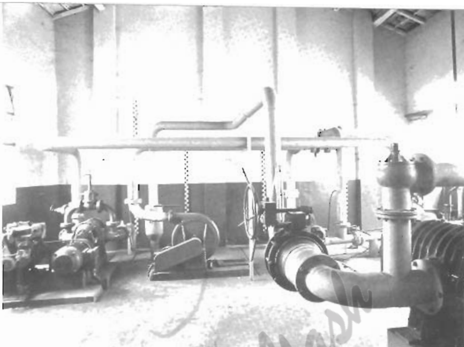
"Il vecchio impianto di distribuzione del gas miscelato" comprensorio di rete
